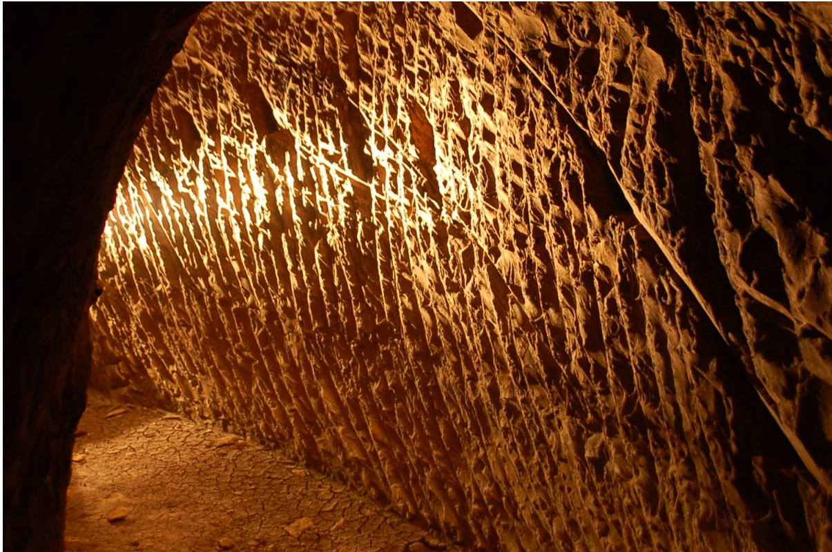
Abb. 7.2: Vortriebsspuren: Schräm Spuren eines Flachmeißels.
