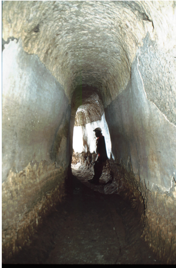
Abb. 10: Verputzter Tunnel (km 109,5)
