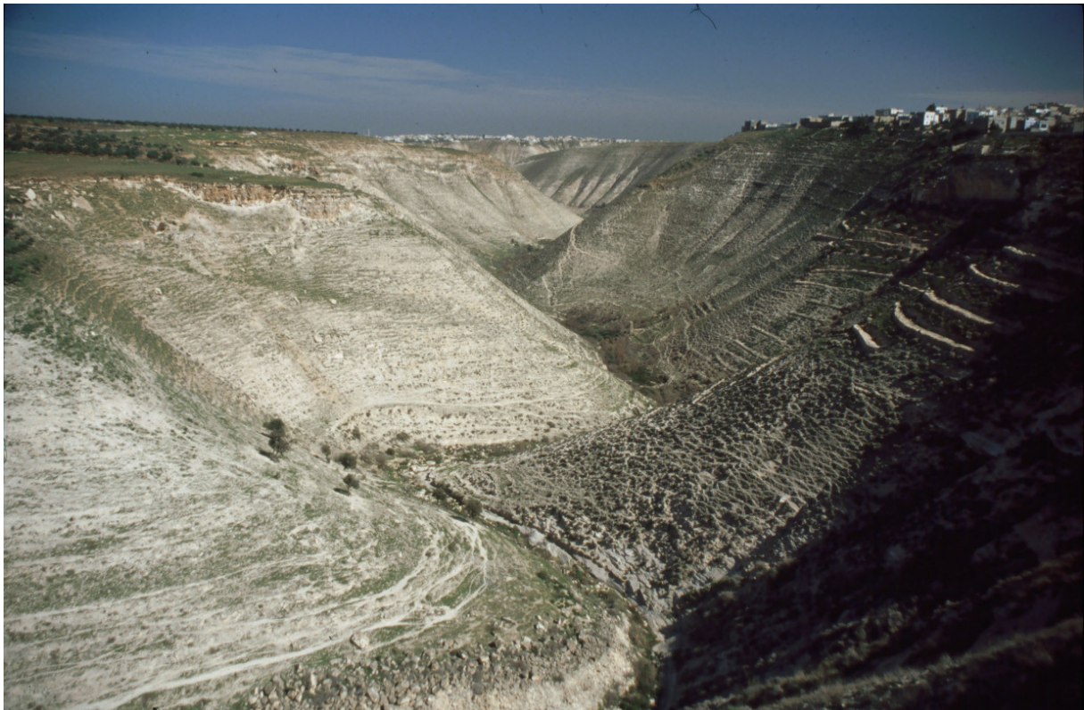
Abb. 5: Seitental des Wādī eš-Šellâle. Der Aquädukt verläuft in etwa 20 m Tiefe im oberen Drittel des rechten Hanges (km 85).
