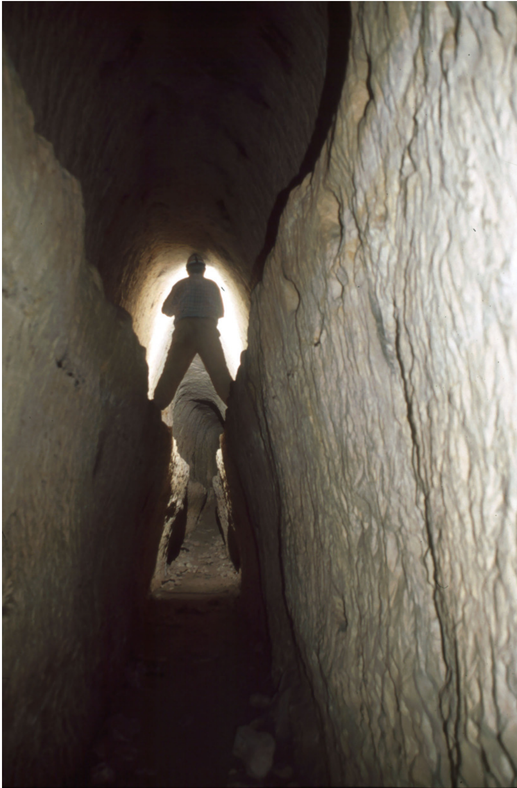
Abb. 12: Höhenfehler: oben der zu hoch liegende Tunnel, unten die korrigierte Lage (km 149).
