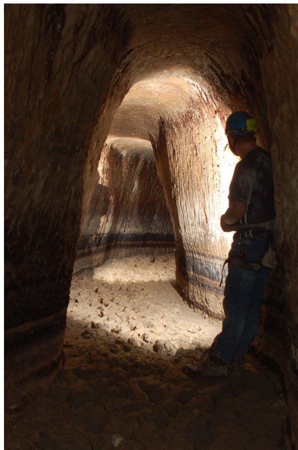
Abb. 11: Aquädukt ohne Dichtung (km 74)
