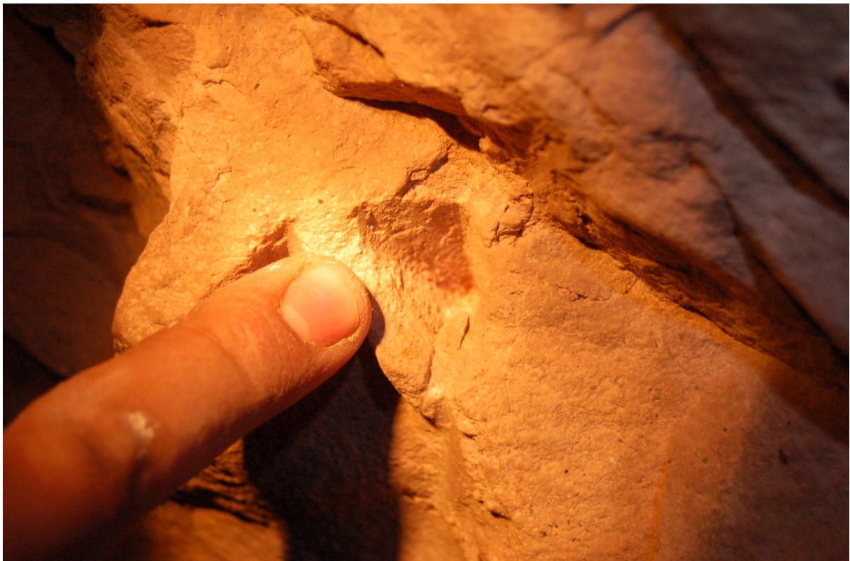
Abb. 7.1: Vortriebsspuren: Quadratischer Spitzmeißel
